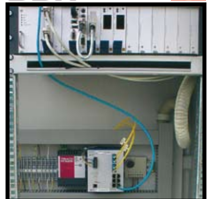
Stationsrechner mit HIRSCHMANN Rail Switch
