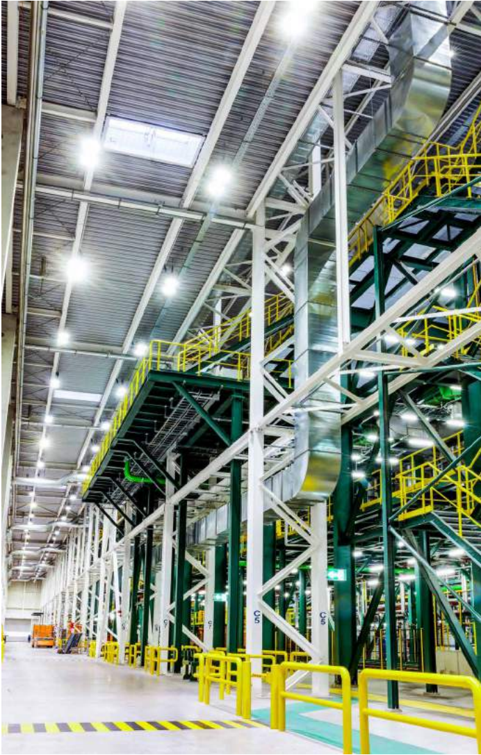
Hallenleuchten-Steuerung mit Hilfe der Kalenderfunktion - Neben ganzen Tagen sind auch uhrzeitspezifische Einstellungen wählbar. Dies ist z.B. dann sinnvoll, wenn in einem Betrieb während der Kernarbeitszeit die komplette Beleuchtung auf 100% geschaltet sein soll.
