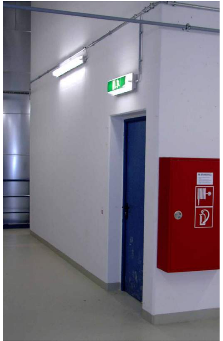
Einbindung von Notleuchten mit Einzelbatterie - Der Betrieb von Notleuchten ist in den folgenden drei Schaltungsarten möglich: Dauerlicht, Bereitschaftslicht und gesteuertes Licht.
