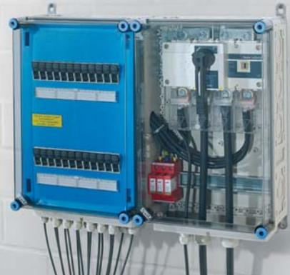
③ Prüfen, ob eine Überspannungs-Schutz-Einrichtung (ÜSE) notwendig ist.
